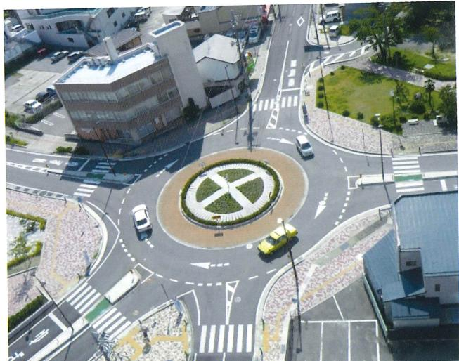
写真5 ランドアバウト周辺へのILブロック舗装の適用例(写真提供:飯田市)
