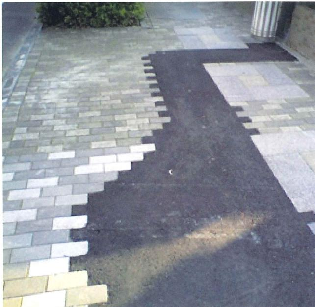
写真6 アスファルト混合物による補修で景観性が損なわれている例
