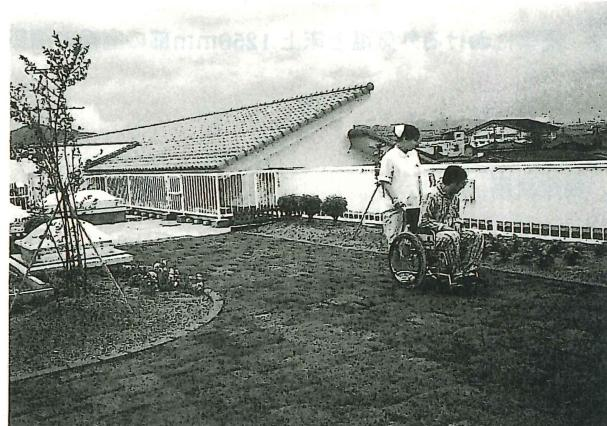
写真5 軽量ポーラスコンクリート屋上緑化システムの病院屋上への適用事例（供用状況）
