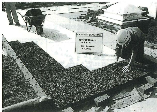
写真4 軽量ポーラスコンクリート屋上緑化システムの病院屋上への適用事例（施工時）
